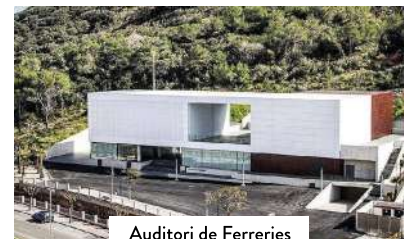
Auditori de Ferreries Av. son Morera, 1 · Ferreries
